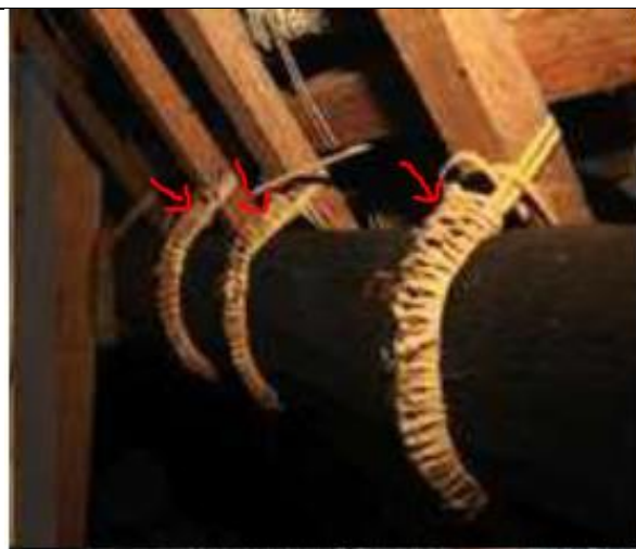
Gambar 11: Teknik sambungan jepit dan terikat pada atap
