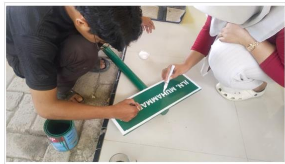
(b) Proses finishing papan nama jalan
