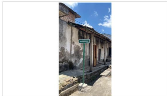
(d) Papan nama jalan setelah pemasangan
