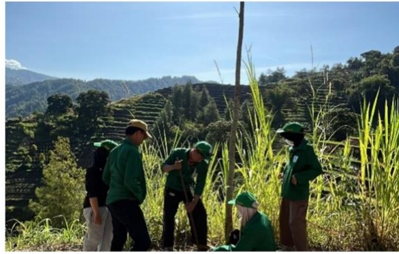
(b) Penggalian titik pemasangan
