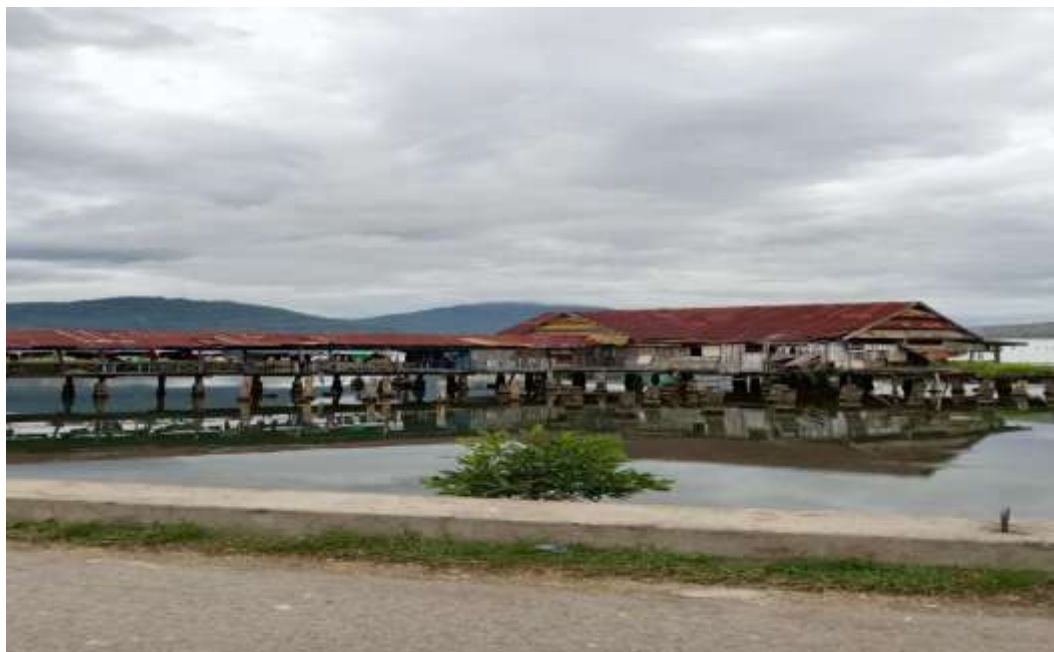
Gambar 1.2 Pembangunan Rumah Dipinggir Laut
