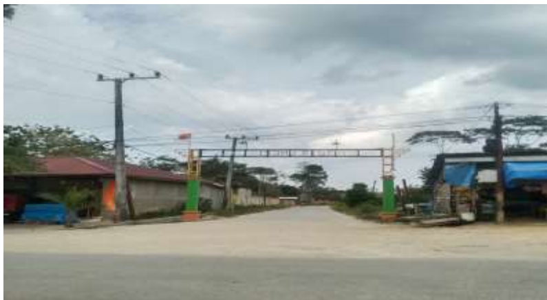
Gambar 4. Jalan masuk perumahan dipaving blok
