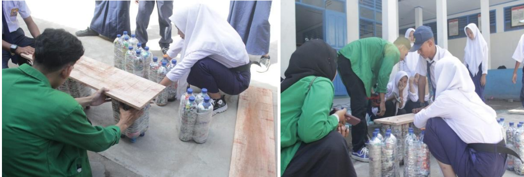
Gambar 4. Proses Pembuatan Bangku dari Ecobrick
