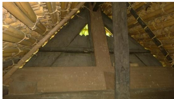
Gambar 7. Dinding segitiga ( para ) Sumber : Dokumentasi, 2017
