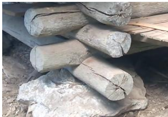
Gambar 3. (Pondasi) Batu Peradangan Sumber: Dokumentasi, 2017
