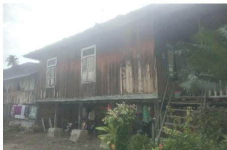
Gambar 2. Stuktur ruangan Rumah Panggung Suku Kaili Sumber : Survey Lapangan 2024
