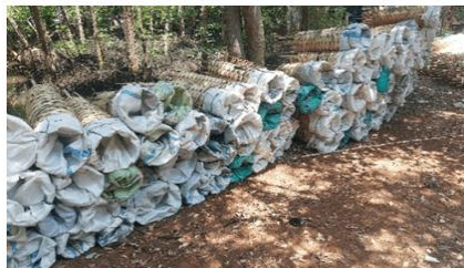
Gambar 2. Pembuatan Bronjong Sumber: Observasi Lapangan, 2024
