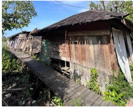
Gambar 3. Kondisi Bangunan Sumber : Dokumentasi Lapangan, 2025
