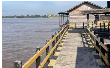
Gambar 6. Kondisi Drainase Lingkungan Sumber : Dokumentasi Lapangan, 2025
