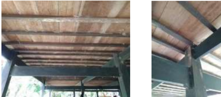
Gambar 6. Hubungan Kolom dengan Balok Induk pada Bola Kaju Sappu' Sumber : Dok Pribadi 2020
