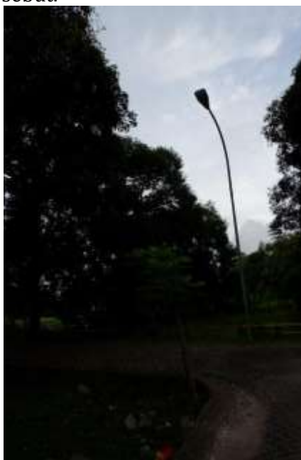
Gambar 1. Kondisi Lampu Penerangan Sumber: peneliti, 2020
