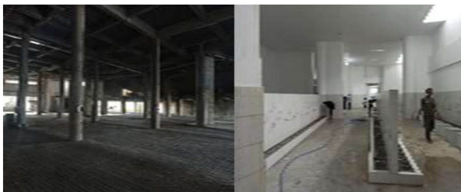
Gambar 11. Basement dan Area Wudhu Sumber (Dokumentasi Pribadi, 2022)
