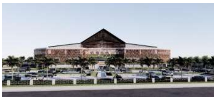
Gambar 2. Bentuk bangunan (Sumber: Olah Data, 2023)
