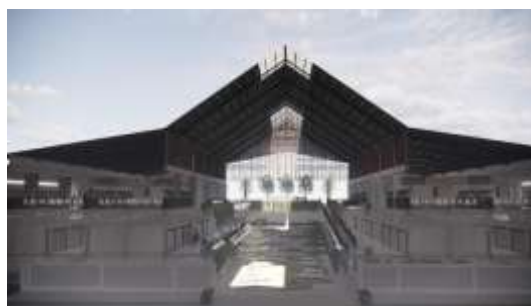
Gambar 8. Pencahayaan, penghawaan alami dan Skylight pada Bangunan (Sumber: Olah Data, 2023)
