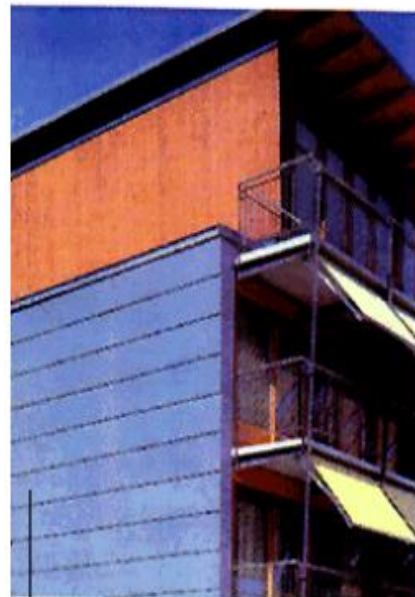
Deretan Modul PV sebagai penutup facade
